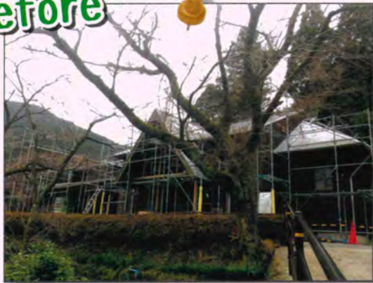
足場を組んでいる時は雪が積もる日もありました。
