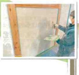
内装壁の仕上げには「幻の漆喰」を左官さんが丁寧に塗って仕上げます。自然素材しか使っていない幻の漆喰は調湿効果、消臭効果はもちろん、空気中の化学物質を吸着分解して、半永久的にクリーンな空気を作ってくれる「天然の空気清浄器」なのです。
