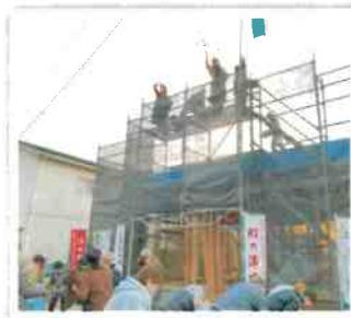
基礎工事が終わるといよいよ棟上げ(上棟式)です。鉄筋コンクリートの基礎の上に土台を敷き、そこに柱を立て、桁・梁・母屋(もや)というふうに組み立てていきます。
