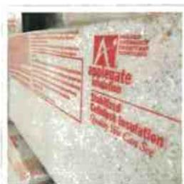
壁の断熱には新聞紙を原料とした「セルロース断熱」を採用しています。小さく碎かれた新聞紙が四角に梱包された状態で現場に搬入され、それを専用の機械で再び碎き、壁内にしっかりと吹付けて行きます。余分な部分をブラシで落とせば壁の断熱は完成です。
