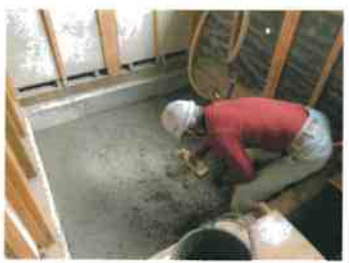
コンクリートを均す 野島大工さんの後ろ姿です
