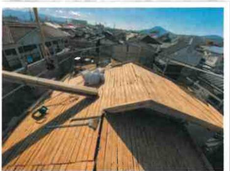
まずは、瓦の撤去から始めます。クレーンで吊った箱に瓦を入れて降ろしています。隣地の方のご厚意によりクレーン車を停めさせていただきましたので作業がはかどりました。(ありがとうございました。)
