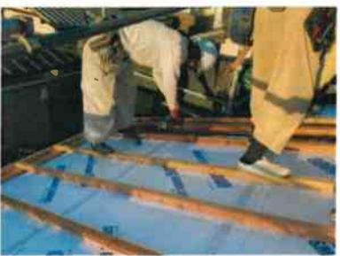
その次に四角の木材を取り付け、その上から構造用合板を張ります。このシートと構造用合板の間の「通気層」と呼ぶ空間は文字通り空気を通す空間です。軒の天井から入って温まった空気は屋根の一番高い棟という部分から抜けしていく仕組みになっています。
