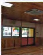
動線が悪かった出入口の位置を変更しました。老朽化しルミサッシに変えガラスはほにも強い強化ガラスのペア。これで隙間風もなくエアコ:
