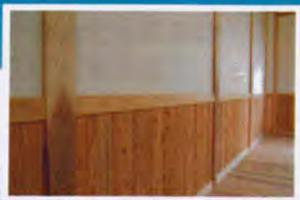
壁は「空気がうまい家」ではもうお馴染みの幻の漆喰と音響時熟成木材の腰壁の組合せです。子供たちが走り回ってぶつかっても良いように腰壁を作っています。手で触ると浮造り(うづくり)の凹凸が気持ちよく感じられます。幻の漆喰は化学物質を吸着分解する働きをはじめ調質・消臭効果もありますのでいつまでも快適に過ごせます。
