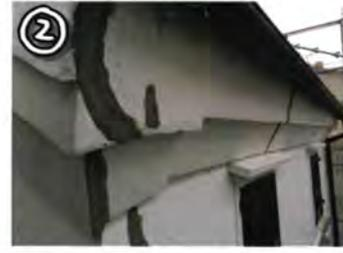
② 外壁のひび割れに沿って専用の機械でU型にカットしその部分の奥側にシーリング材を充填してカチオンと呼ばれる外壁補修材で埋戻したところです。これに研磨をかけて平滑にしたあと上塗りをしていきます。
