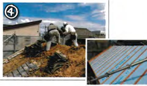
④ 屋根の瓦を剥がしている様子です。瓦の下には「葺き土」と呼ばれる土が厚く敷かれています。昔はこういった瓦の葺き方をしていました。この葺き土には飛び火から建物を守る役目とまた断熱の効果もあります。
