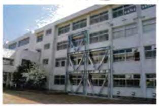
学校の外壁に鉄骨を取付けて補強しました
