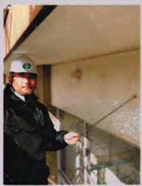
まずは外壁の調査から。「打診棒」で叩いて音を聞いたリ、「目視」で外壁の状態をみてモルタルの浮き等を調査します。モルタルが浮いたままだと欠落する恐れがあり危険です。
