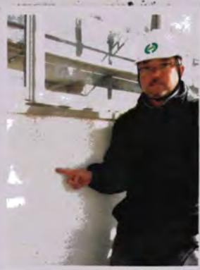
クラック(ひび割れ)です。建物の内部に雨水が浸入する恐れがあるので改修します。
